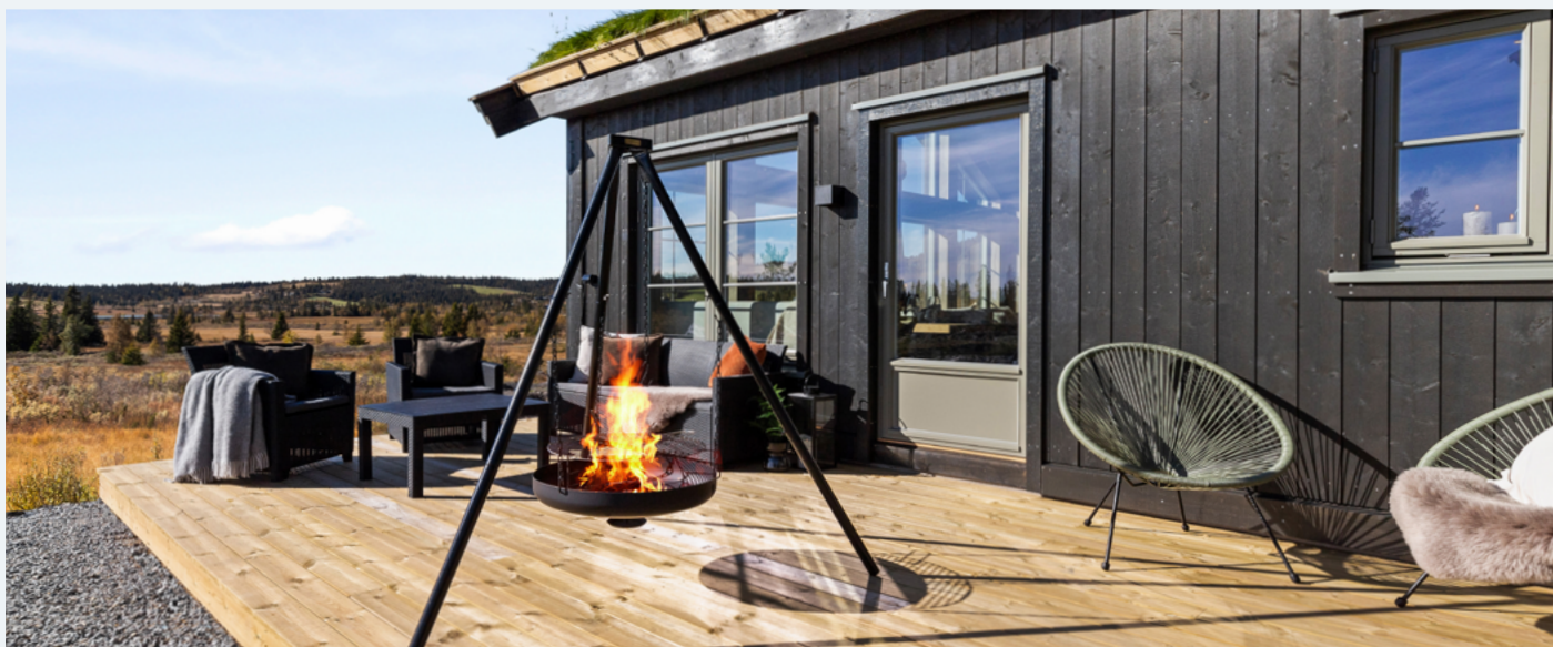
Bildet viser Furu (28x120) impregnert som er lagt på en Spåtind 85 modell.
